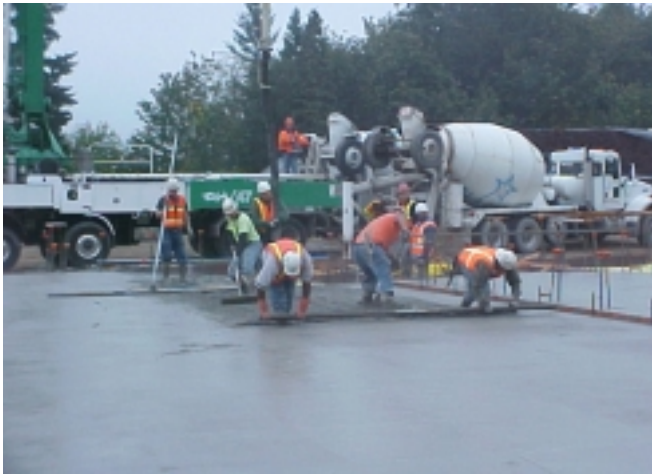
Slab on grade pour at the Gym.
